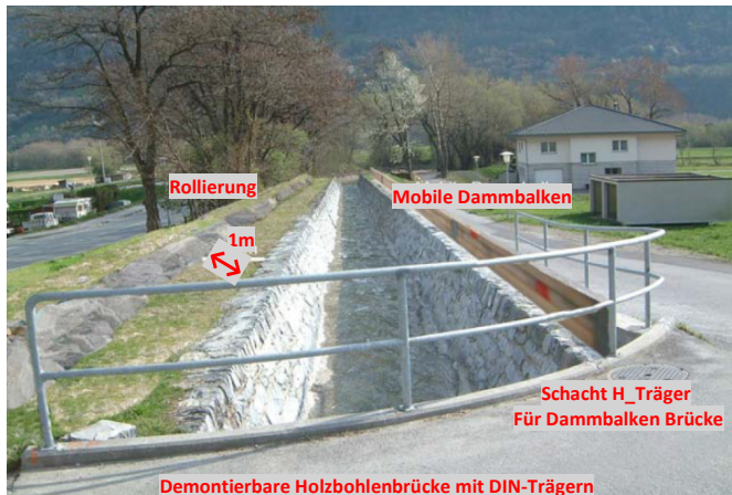
Hochwasserschutzkonzept Jolibach Foto: Ausgeführte Sofortmassnahmen
